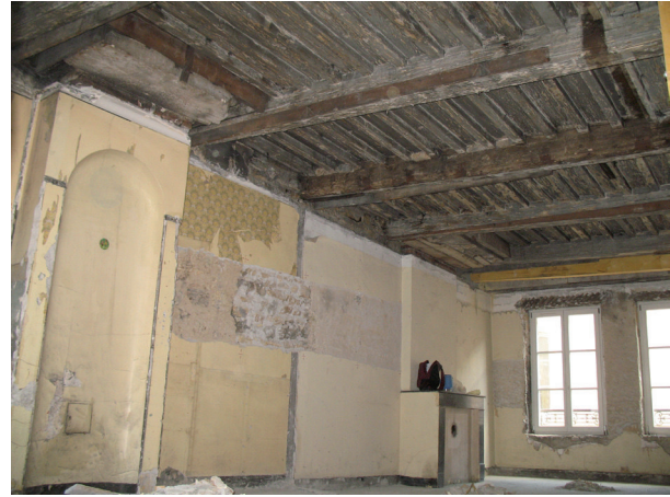
Abb. 6: Metz, Moselle (57), „Rue Taison“. Hier konnte bei bauarchäologischen Untersuchungen ein Gebäude aus der ersten Hälfte des 17. Jahrhunderts dokumentiert werden, dass sich durch Balkendecken mit hölzernen Unterzügen sowie durch Kamine des 18. Jahrhunderts auszeichnete, die nachträglich an die Zwischenwände angesetzt worden waren. Ferner konnten Spuren der ehemaligen Farbfassung und Dekoration der Räume nachgewiesen werden. Die detaillierte Beobachtung und Dokumentation des aufgehenden Mauerwerks erlaubt es häufig, den ältesten Baubestand eines Gebäudes festzustellen und die Gebäudeentwicklung über die Jahrhunderte zu verfolgen (Foto: I. Ferraresso, Inrap).
