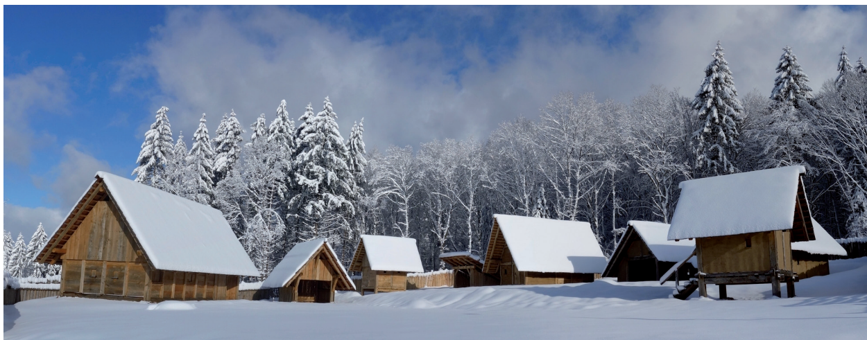
Das Keltendorf im dritten Bauabschnitt, Februar 2015. / L'hameau celté en février 2015. Troisième phase de construction (Foto: M. Koch).
