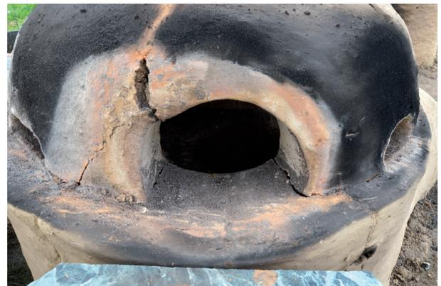
Abb. 5: Risse in der Ofenkuppel nach dem Borg Furnace Project 2013 [Foto: F. Wiesenberg].
