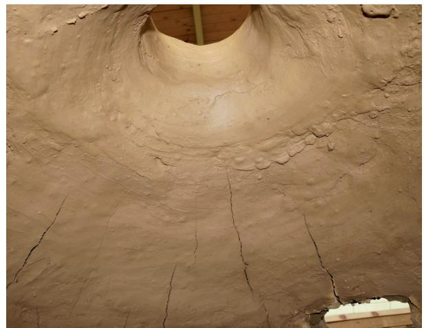
Abb. 10: Moderate radiale Trocknungsrisse im Inneren der Kuppel des Glasofens [Foto: F. Wiesenberg].
