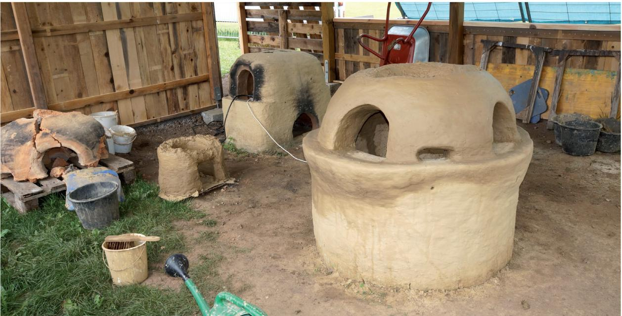
Abb. 8: Glashütte der Villa Borg. Restaurierter Glasofen und Kühlöfen, dazwischen Perlenöfen (im Bau), links dahinter die abgetragene Ofenkuppel des Glasofens [Foto: F. Wiesenberg].
