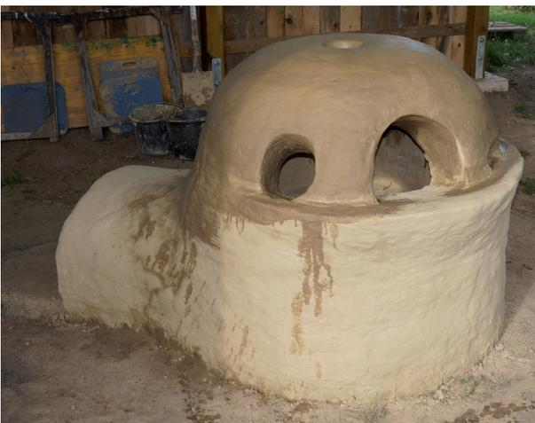
Abb. 9: Der Glasofen wurde für das Borg Furnace Project 2014 um eine dritte Arbeitsöffnung ergänzt [Foto: F. Wiesenberg].
