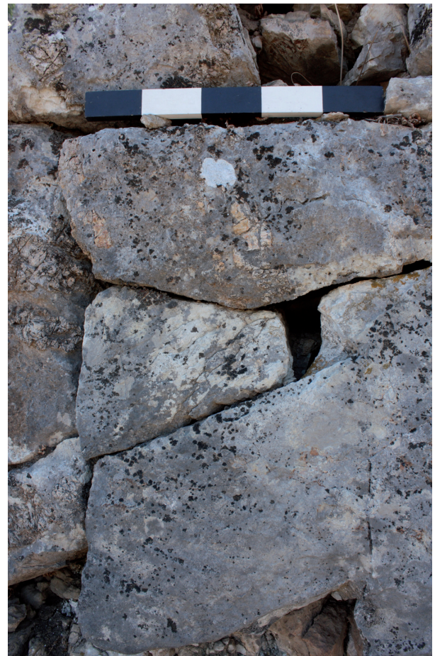
Abb. 17: AT1 Frontmauer - Detail [Foto: B. Özen-Kleine].
