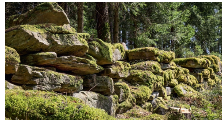
Rinkenmauer bei Baiersbronn (Foto: Stefan Karl, CC BY-SA 4.0)
